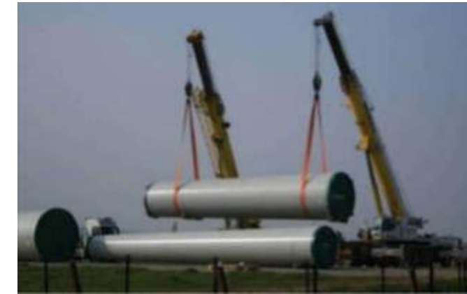
Figure 18 : Aire de grutage et déchargement des tronçons d'un mât (Source : JPe)
