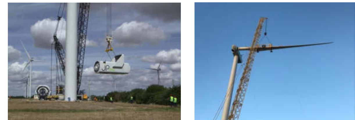
Montage de la nacelle
