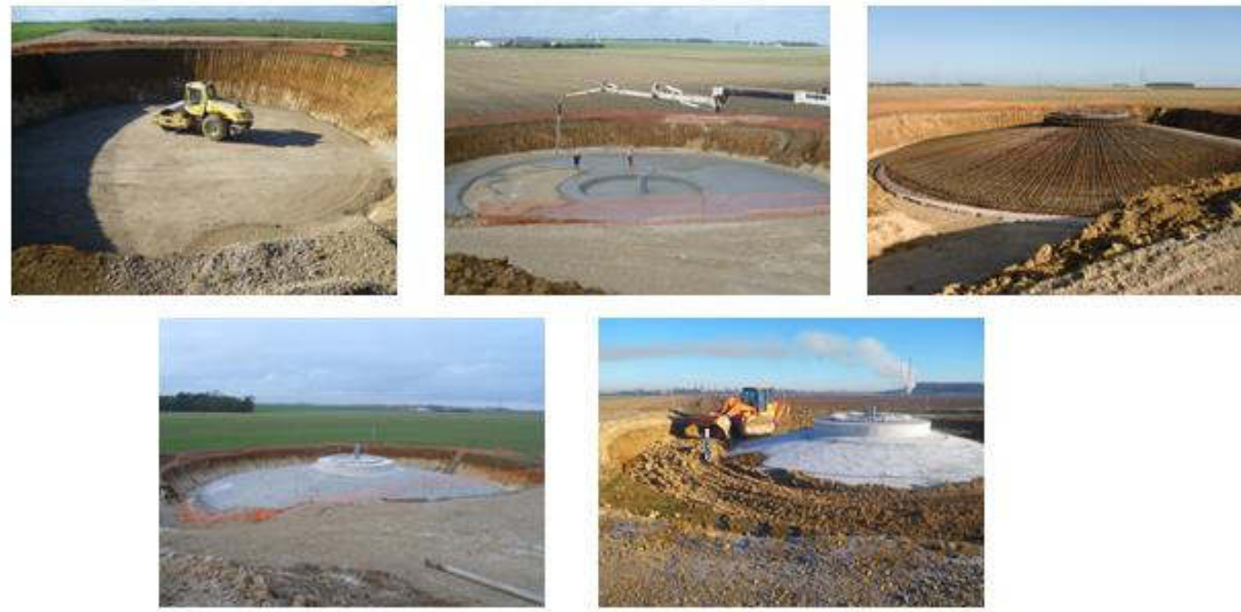
Figure 19 : Photographies de la réalisation des fondations (Source : JPee)
